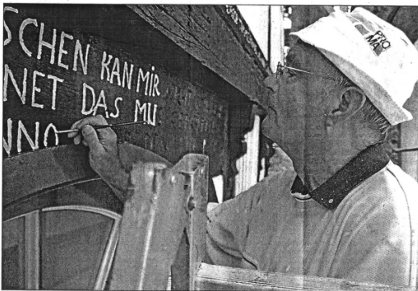
Mit dem Pinsel taucht Maler Wolfgang Beck in den Farbtopf, dann zieht er die feinen Linien der Hausinschrift nach und verziert die Ornamente. Bis Ende Juli sollen die Malerarbeiten abgeschlossen sein.
