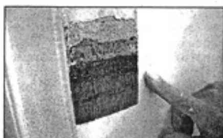
Unter den Lack geschaut: Schichten aus verschiedenen Epochen.
